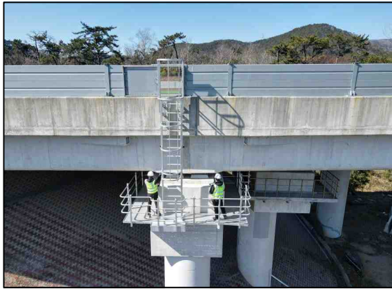
a. 교각 점검통로 전경
