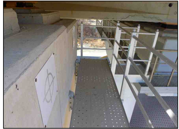
b. 교각 점검통로 전경
